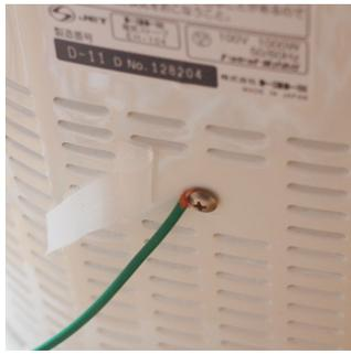
④ストーブなどは金属部からストーブなど端子も何も無い電化製品は、金属部分からアースを取ります。写真は、ネジ止めしてあるところを利用しています。
